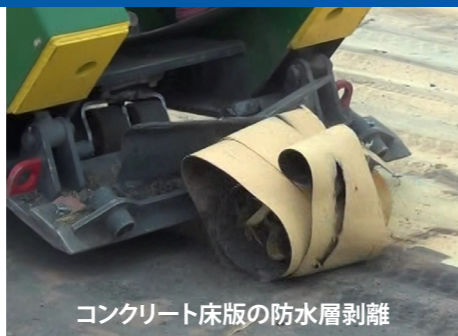
パワーショベルによる従来工法 作業効率が悪く、騒音が大きく粉塵が発生
